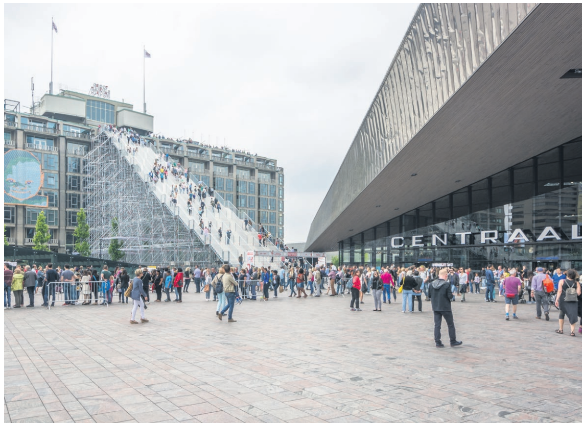
De tijdelijke trap naar het dak van het Groothandelsgebouw trok in 2016 veel belangstellenden. Arie van der Stoep kon er toen helaas niet bij zijn
